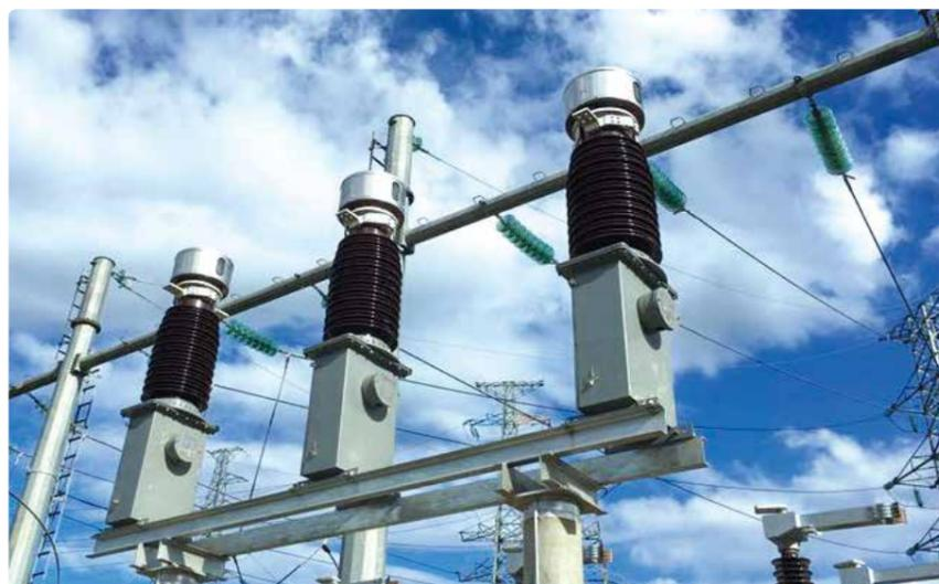
广州供电局研制的世界首台一体化智能检测电流互感器实现从停电试验到带电测试的智能化切换和运维
